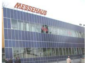
(17 kWp Anlage – Welser Messehaus)
