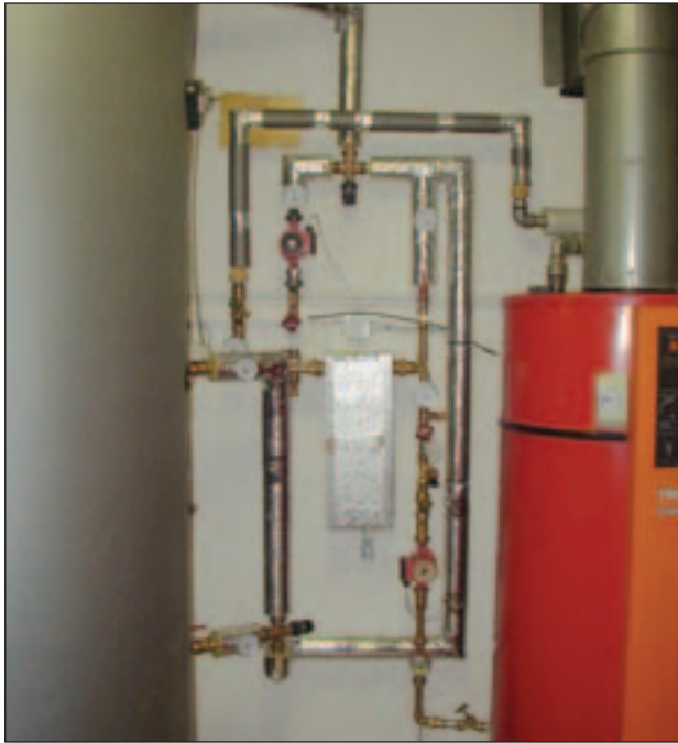
Abb. 5.18 Pufferentladekreis; Quelle: ASiC
