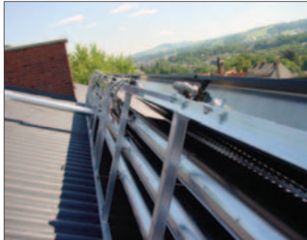
Abb. 5.7 Kollektorfeldverrohrung; Quelle: ASIc
