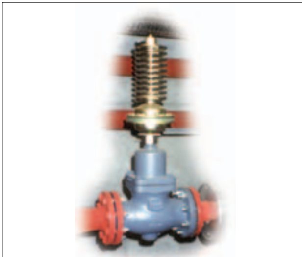
Abb. 5.16 Hauptsicherheitsventil einer Großanlage; Quelle: ASiC
